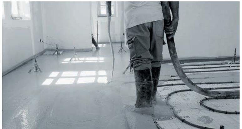
**Agilia CHAPE THERMIC C-1000/C-1100/C-1200 sont des chapes autonivelantes à base de ciment, fibrées ou non. Leurs performances sont garanties par un DTA (Document Technique d'Application), délivré par la CCFAT.**
