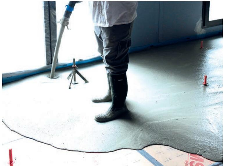
**Agilia CHAPE NIVEL C-1000 / C-1100 / C-1200 sont des chapes autonivelantes à base de ciment, fibrées ou non. Leurs performances sont garanties par un DTA (Document Technique d'Application), délivré par la CCFAT.**
