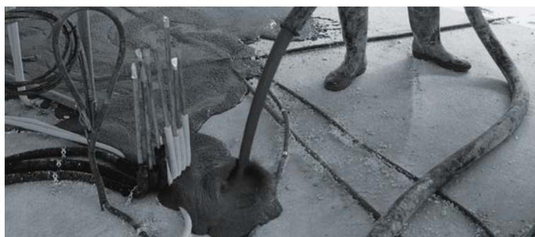
**Agilia RAVOIRAGE C-1000 est un mortier fluide à base de ciment destiné à la réalisation de ravoirages fluides.**
